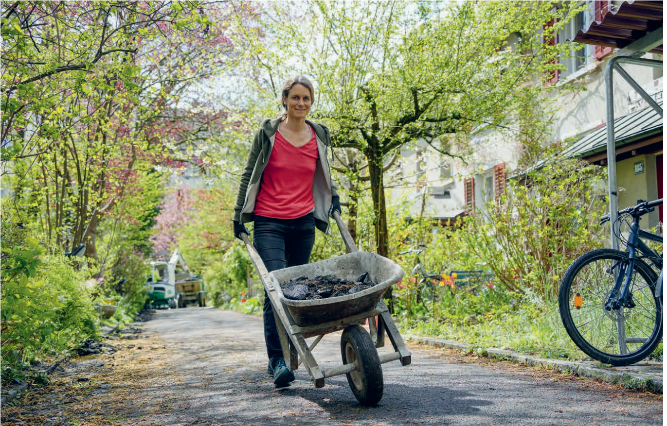
Isabella Sedivy entsiegelt eine Zufahrtstrasse in einer Siedlung der Wohnbaugenossenschaft ABZ, Zürich. Isabella Sedivy casse l'asphalte sur une route d'accès dans la coopérative d'habitation ABZ, à Zurich.
