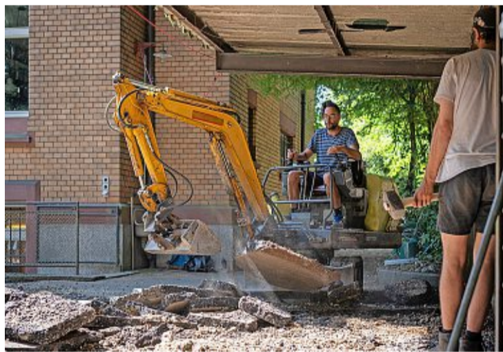
Mit dem kleinen Bagger reiss Matthias den Boden auf, indem er die Asphaltsschicht schrittweise anhebt, bis sie bricht.
